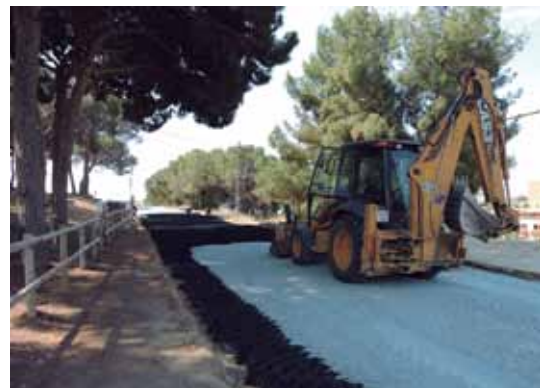
Al tram del Bosquet s'ha estabilitzat el ferm amb geocel·les.
