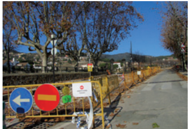
La primera fase de les obres de pavimentació es van iniciar el 3 de desembre.
