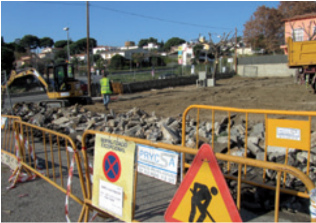
Les obres al carrer Rosaleda van començar a mitjans de desembre
