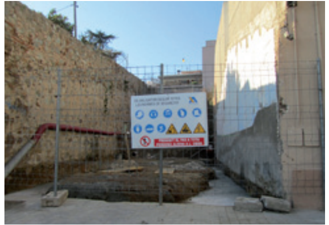
Les obres dels habitatges socials del Canonge ja estan en marxa.
