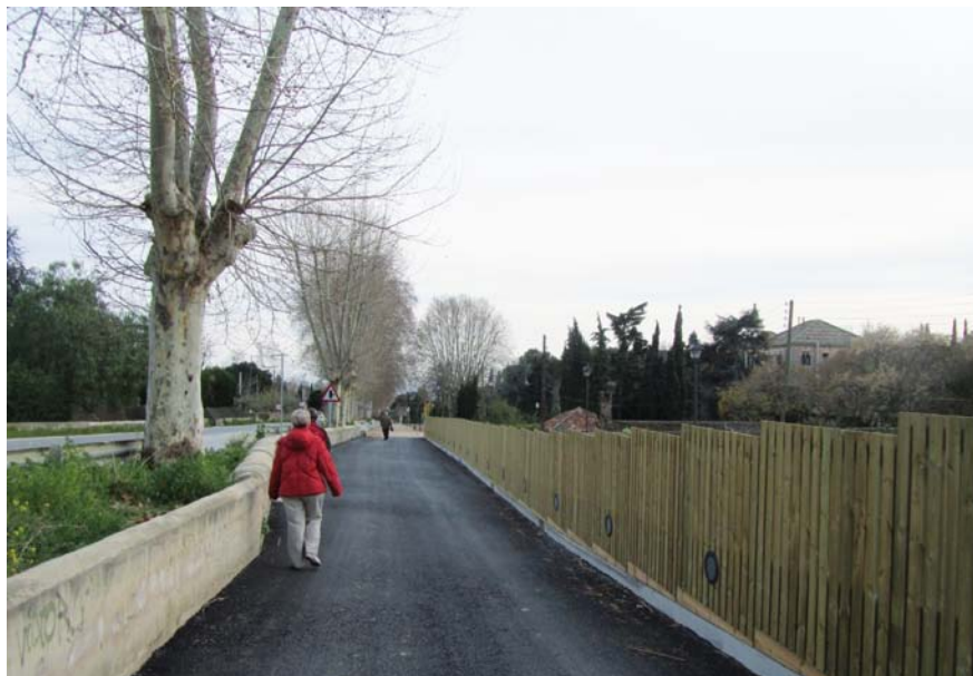
A la banda dreta del pou sorrenc s'ha instal·lat una tanca de fusta i s'ha pavimentat el pas.
