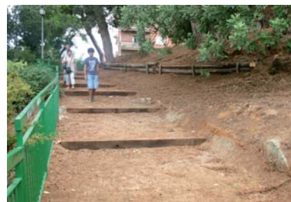
Travesses de fusta a la Plana d'en Gurri, al Rost.
