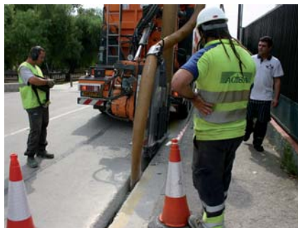
Obres de la xarxa de fibra òptica.
