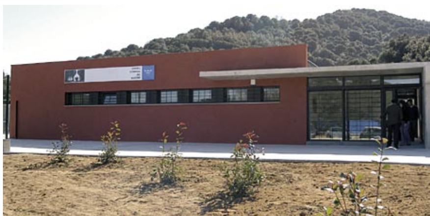
Les instal·lacions del centre es troben a Can Carmany, a Argentona.
