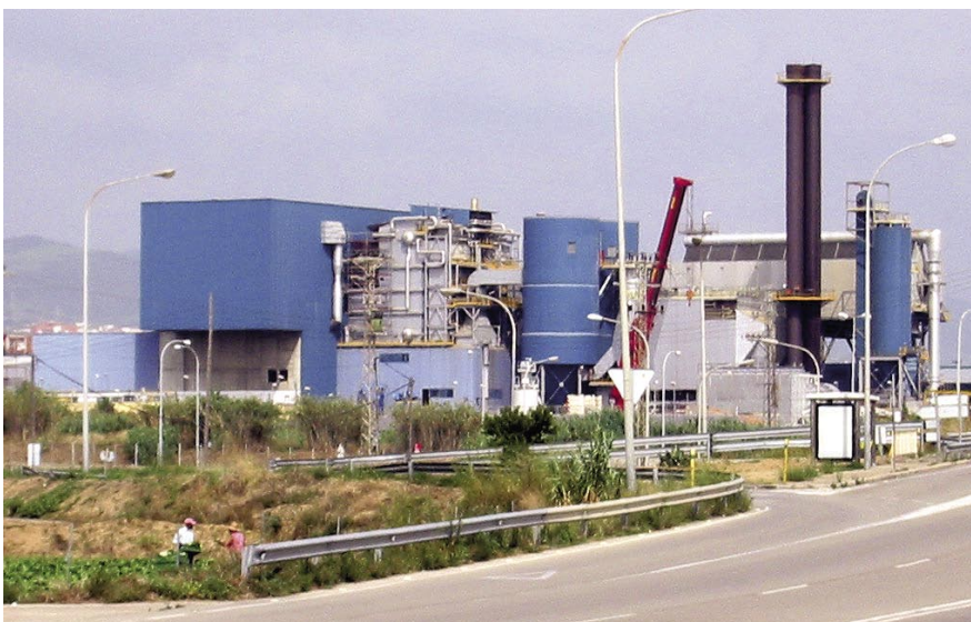
Planta incineradora de Mataró.
