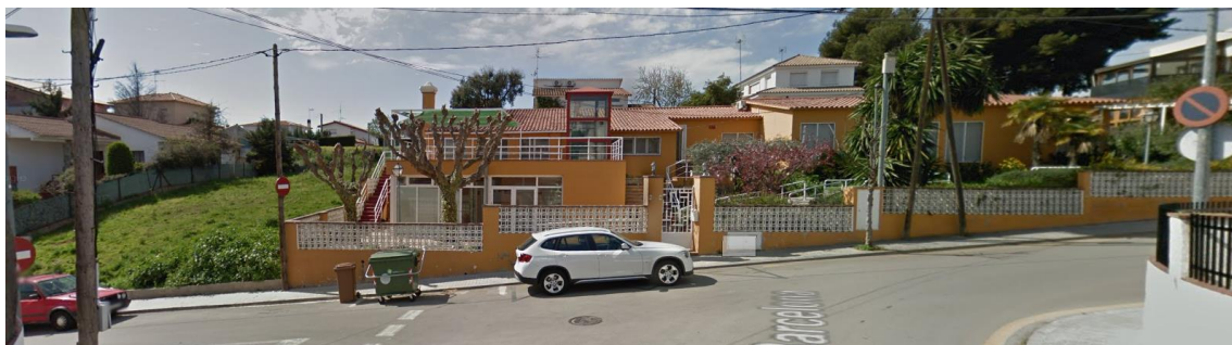
Fotografia estat actual façana C/de la vinya (previ a l'enderroc de l'edificació existent en la parcel·la)
